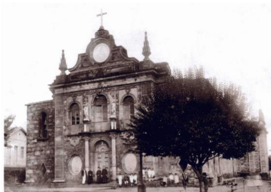
FIGURA 9 - Imagem da Igreja Matriz Nossa Senhora de Montserrat em construção, no séc. XIX. Fonte: Arquivo próprio.
