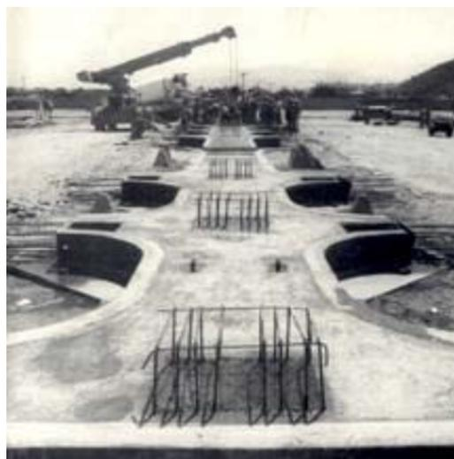
**Figura 35:** Estrutura pré-moldada em concreto armado dos CIEPs.
