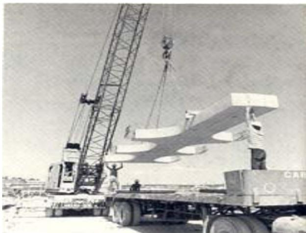
**Figura 36:** Estrutura pré-moldada em concreto do CIEPs.
