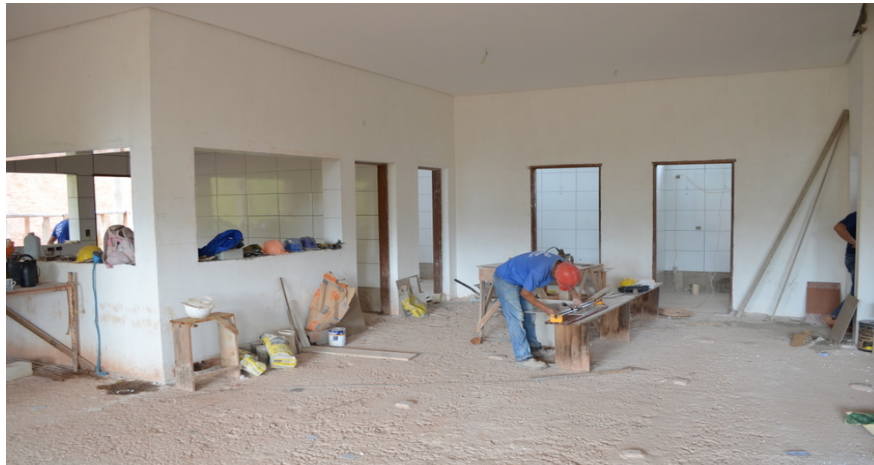
Figura 27: Obras e reformas no Campus Machado. Fonte: Arquivo próprio do autor, 2017.
