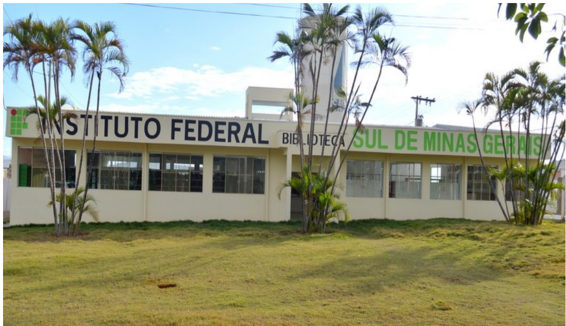
Figura 30: Campus Passos – Biblioteca do Campus. Fonte: Foto de arquivo próprio – 2016.
